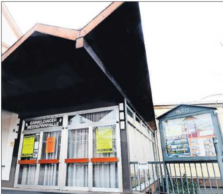
2014 soll die Sanierung der Meerspinnhalle beginnen. FOTO: LINZMEIER
