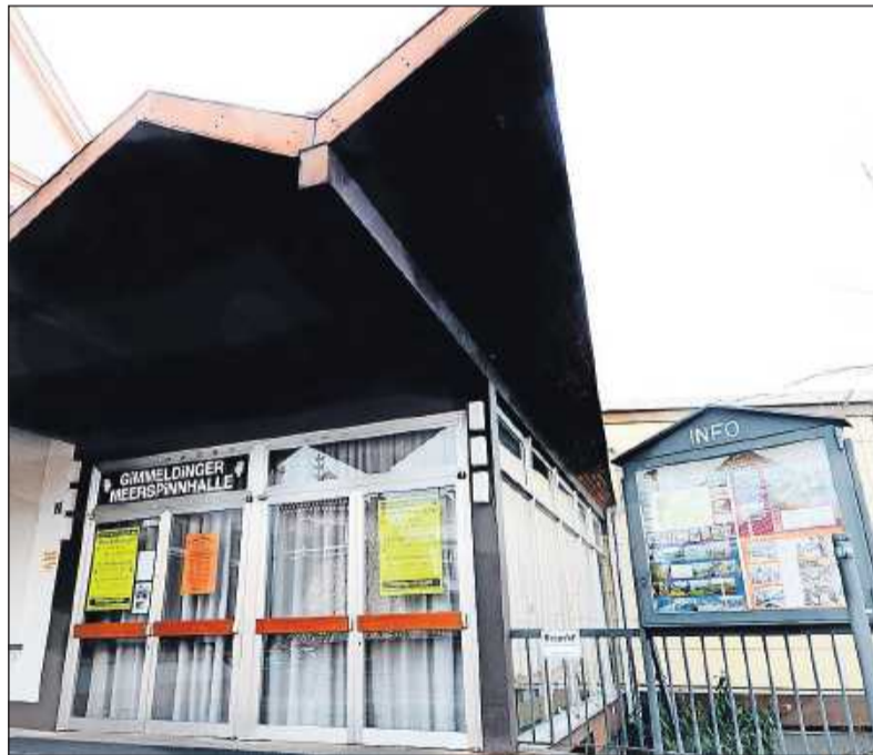
2014 soll die Sanierung der Meerspinnhalle beginnen.
